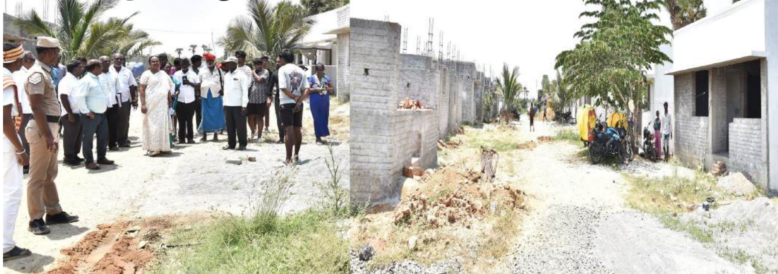
வேலூர் மாவட்ட ஆட்சித்தலைவர் வே.இரா.சுப்புலட்சுமி காட்பாடி ஊராட்சி ஒன்றியம், புத்தூர் ஊராட்சியில் கலைஞர் கனவு இல்லம் திட்டத்தின்கீழ் நரிக்குறவர்களுக்கு கட்டப்பட்டு வரும் 40 குடியிருப்புகளின் கட்டுமான பணிகளை பார்வையிட்டு ஆய்வு செய்தார். இந்த ஆய்வின்போது உதவி இயக்குநர் (ஊராட்சிகள்) திருமால், ஊரக வளர்ச்சி செயற்பொறியாளர் சீனிவாசன், வட்டார வளர்ச்சி அலுவலர்கள் நந்தகுமார், கனகராஜ், வட்டாட்சியர் ஜெகதீஸ்வரன் உட்பட பலர் உடனிருந்தனர்.
